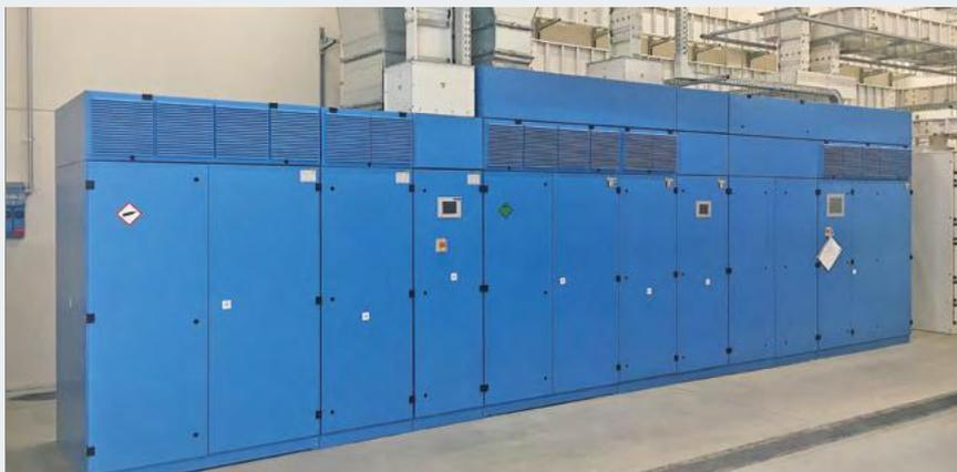
Nella foto qui sopra e in alto, l'accumulatore di energia elettrica a massa rotante a bassa velocità, di potenza 1,5 MW e 64MJ di energia in accumulo, prodotto dalla Piller Spa. È composto da volani in metallo che girano sospesi magneticamente in un'atmosfera di elio a bassissima resistenza, una tecnologia collaudata e semplice che oggi assume una nuova vita; non ci sono batterie, nè piombo, nè litio.
