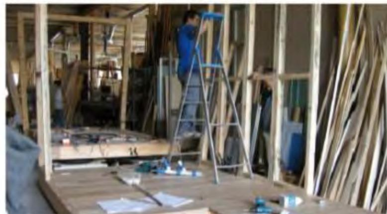
Fig. 4 Realizzazione della parete a telaio del terzo modulo
