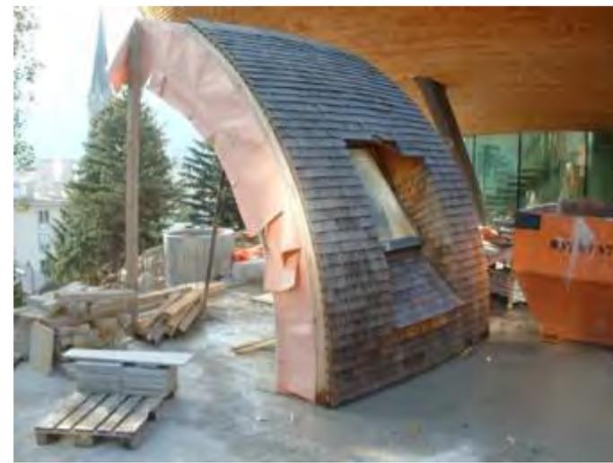
Il “pacchetto” delle pareti esterne comprende le scandole, i listelli, la struttura curva lamellare, la camera d’aria con l’isolamento termico e la controparete in cartongesso
