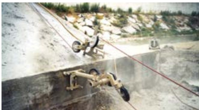
Alcuni interventi di demolizione controllata effettuati dalla B.R. Demolizioni Srl
