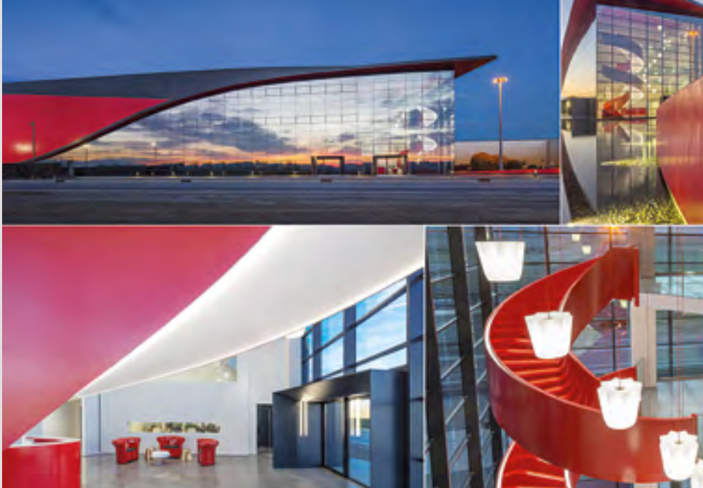
Alcuni degli interventi fatti dalla Frea & Frea Srl per la realizzazione della nuova sede della Maina Panettoni Spa di Fossano [Foto: Maina]
