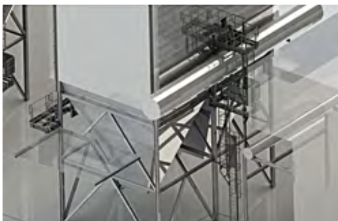
Esempio di scala d'accesso per la manutenzione dei filtri
