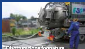
Disotturazione fognature
