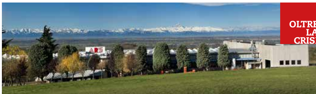
Il nuovo stabilimento di Ars Elettromeccanica a La Morra si estende su 9 mila mq tra uffici, produzione e magazzino
